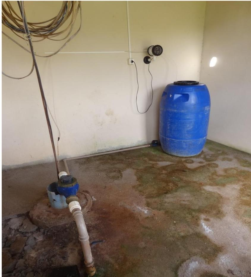
**Figura 8:** Sistema de tratamento do Poço 1 (Sistema de injeção de cloro).
