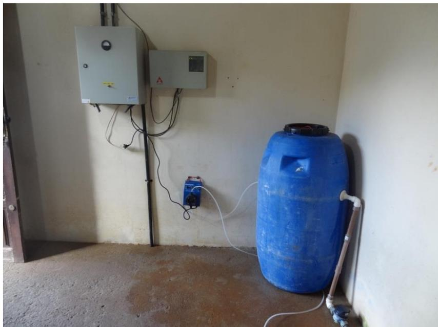
**Figura 10:** Sistema de tratamento do Poço 3 (Sistema de injeção de cloro).
