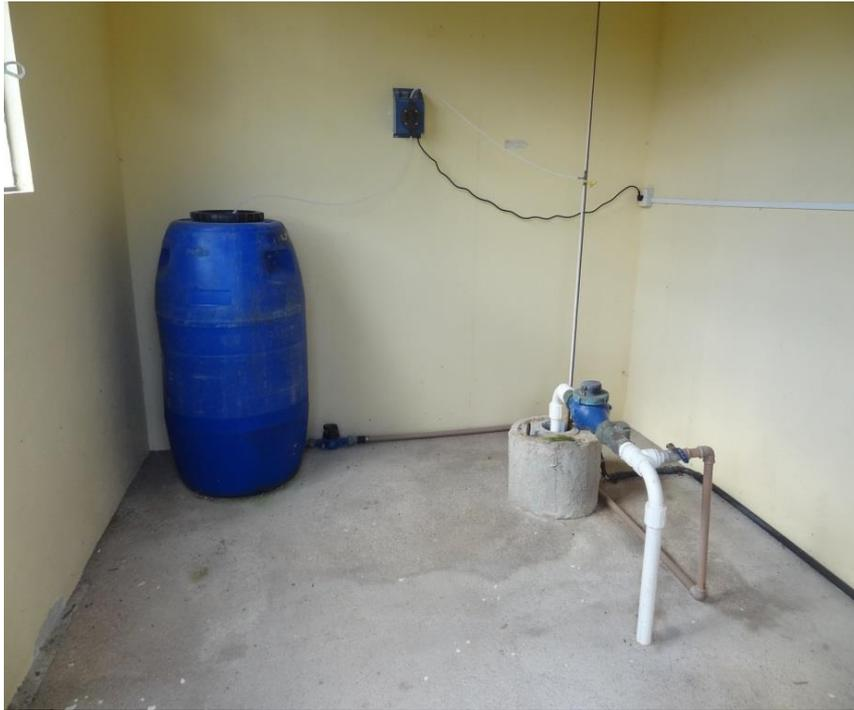
**Figura 9:** Sistema de tratamento do Poço 2 (Sistema de injeção de cloro).
